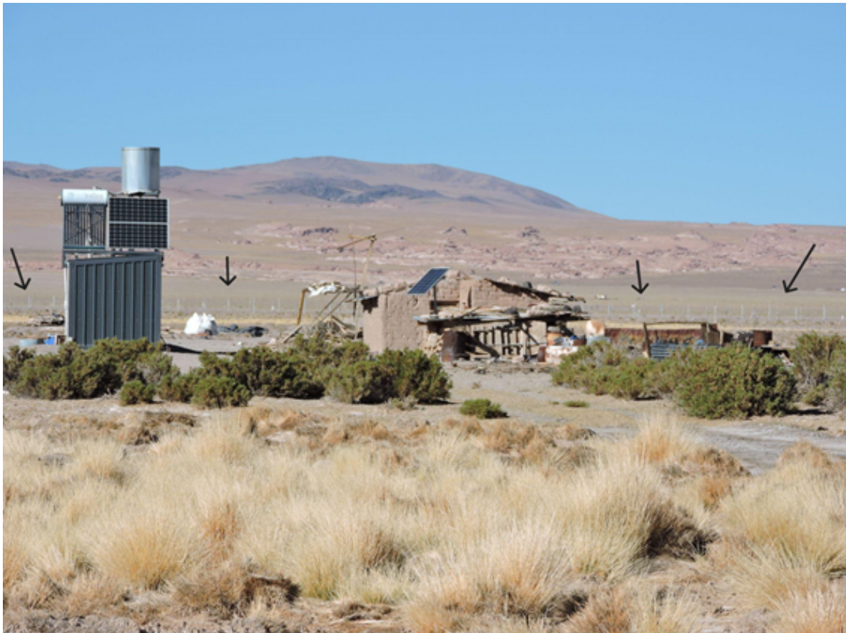
Fotografía 27: Cerco de la pista de aterrizaje de la empresa minera atravesando territorio ancestral y dividiendo las viviendas de la familia Condori.
